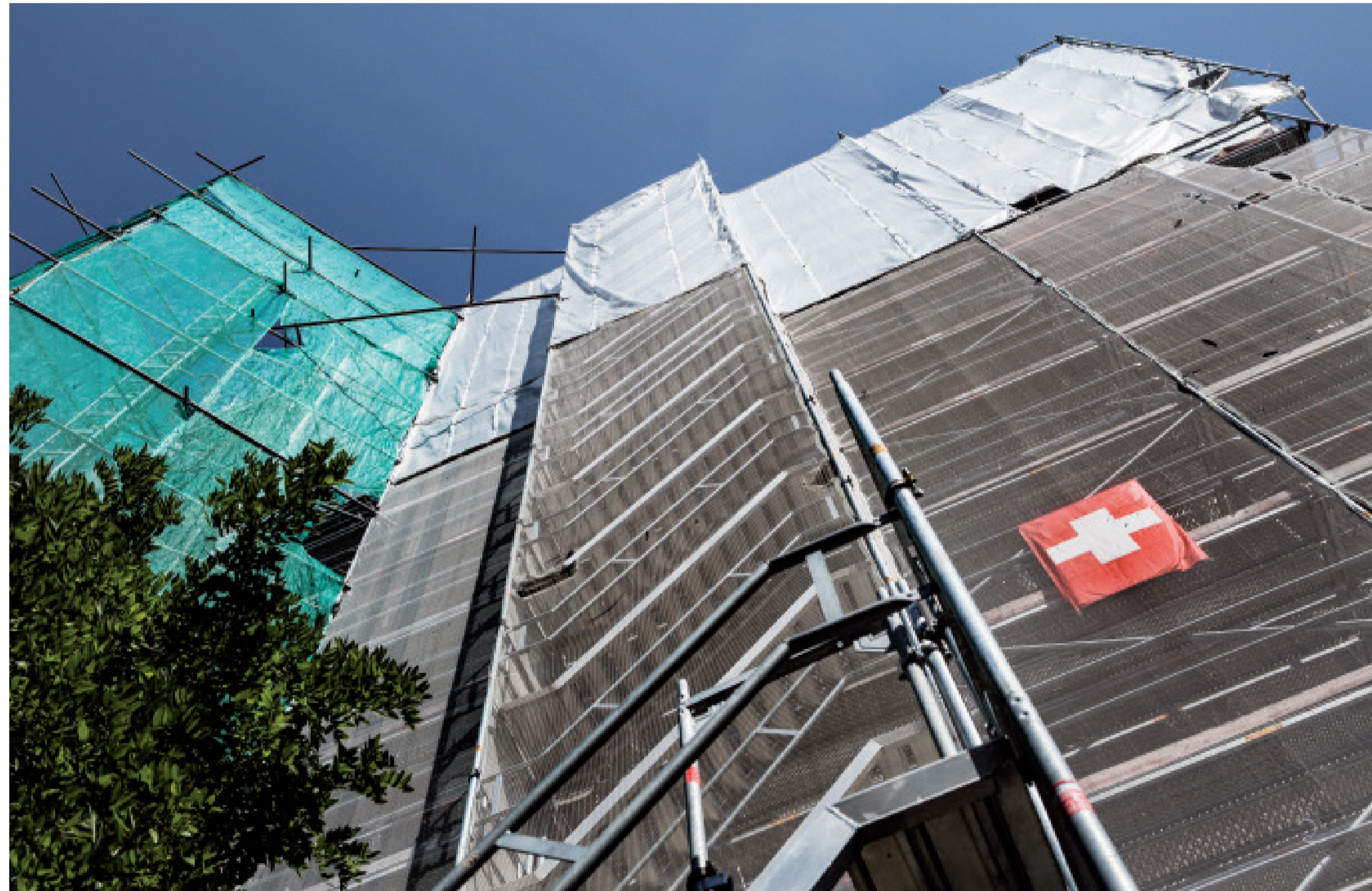
CHANTIER À LA RUE DE LA SERVETTE 76-78, À GENÈVE.
